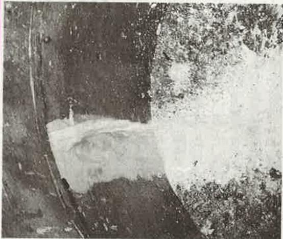
浸入水箇所からの止水剤滲みで充填確認
